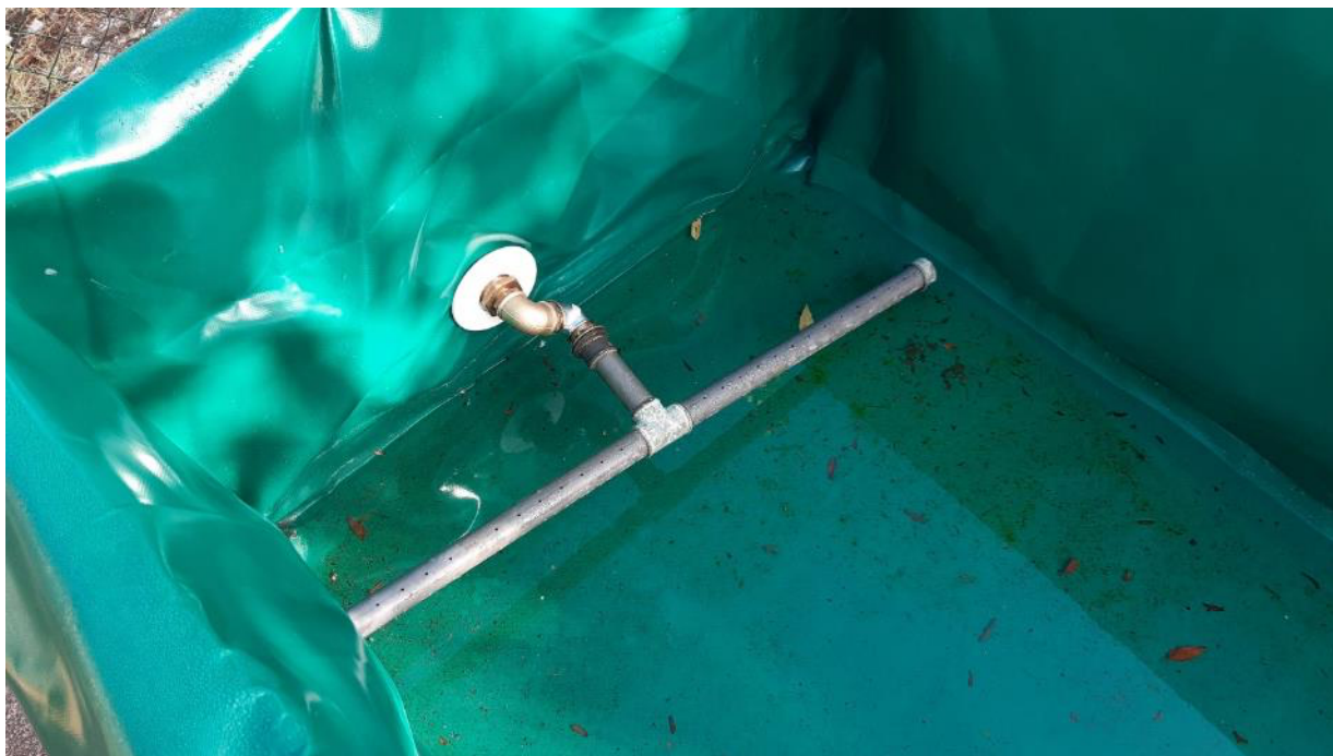
Fig. 6.9 – Realização de testes de estanquidade da tela de impermeabilização e de circulação da água.
