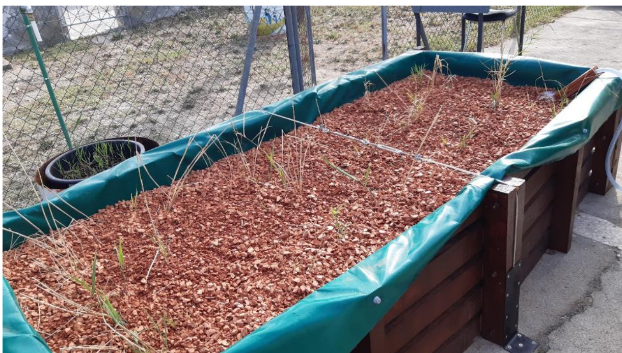
Fig. 6.17 – Plantação das macrófitas na ZHC modular.
