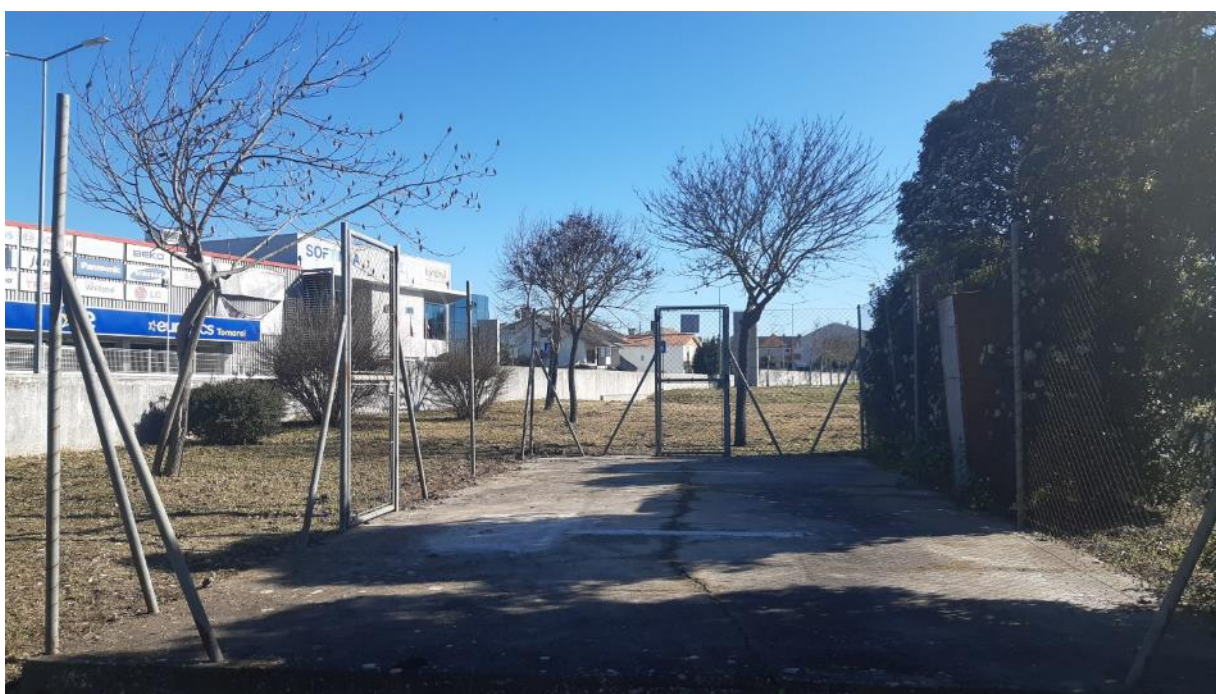
Fig. 6.3 – Zona de implementação da ZHC modular num espaço exterior do IPT, depois de recuperado, durante a substituição da rede de proteção.
