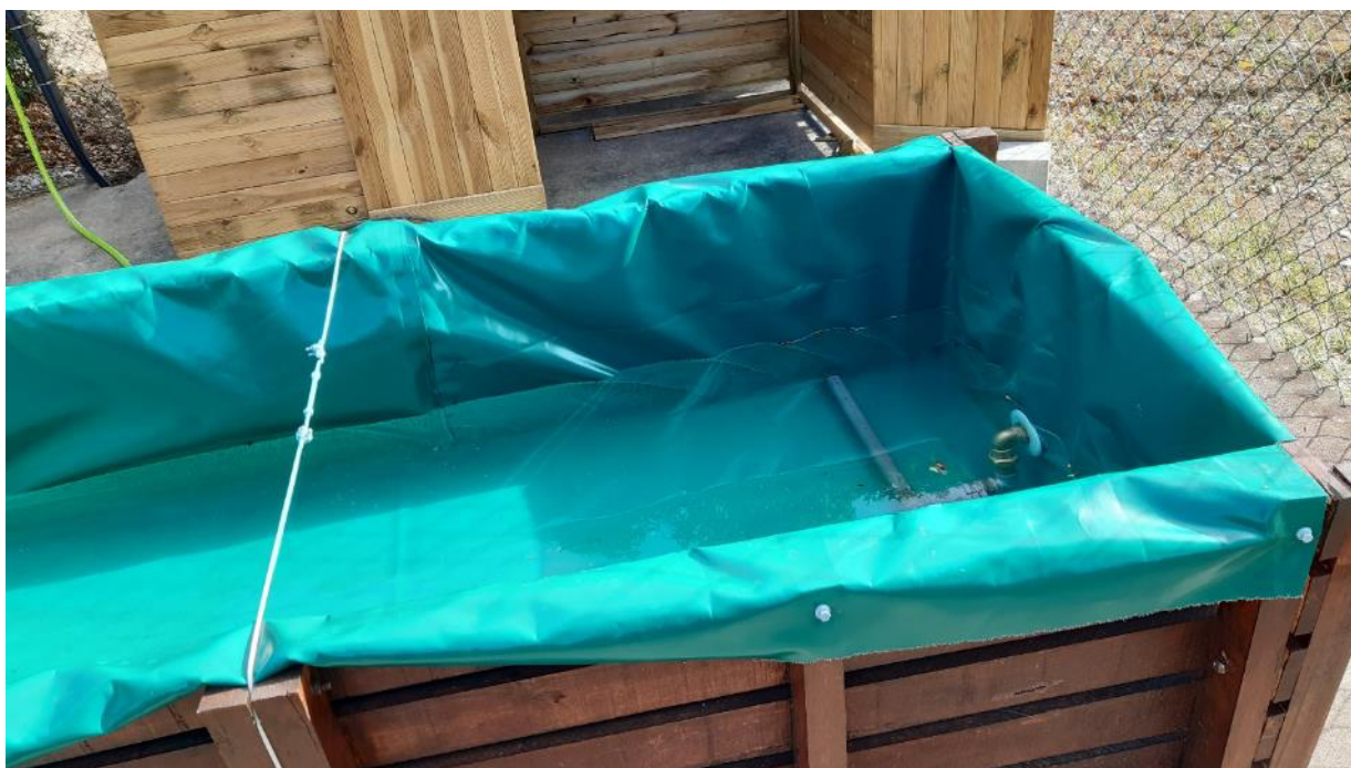
Fig. 6.10 – Realização de testes de estanquidade da tela de impermeabilização e de circulação da água.
