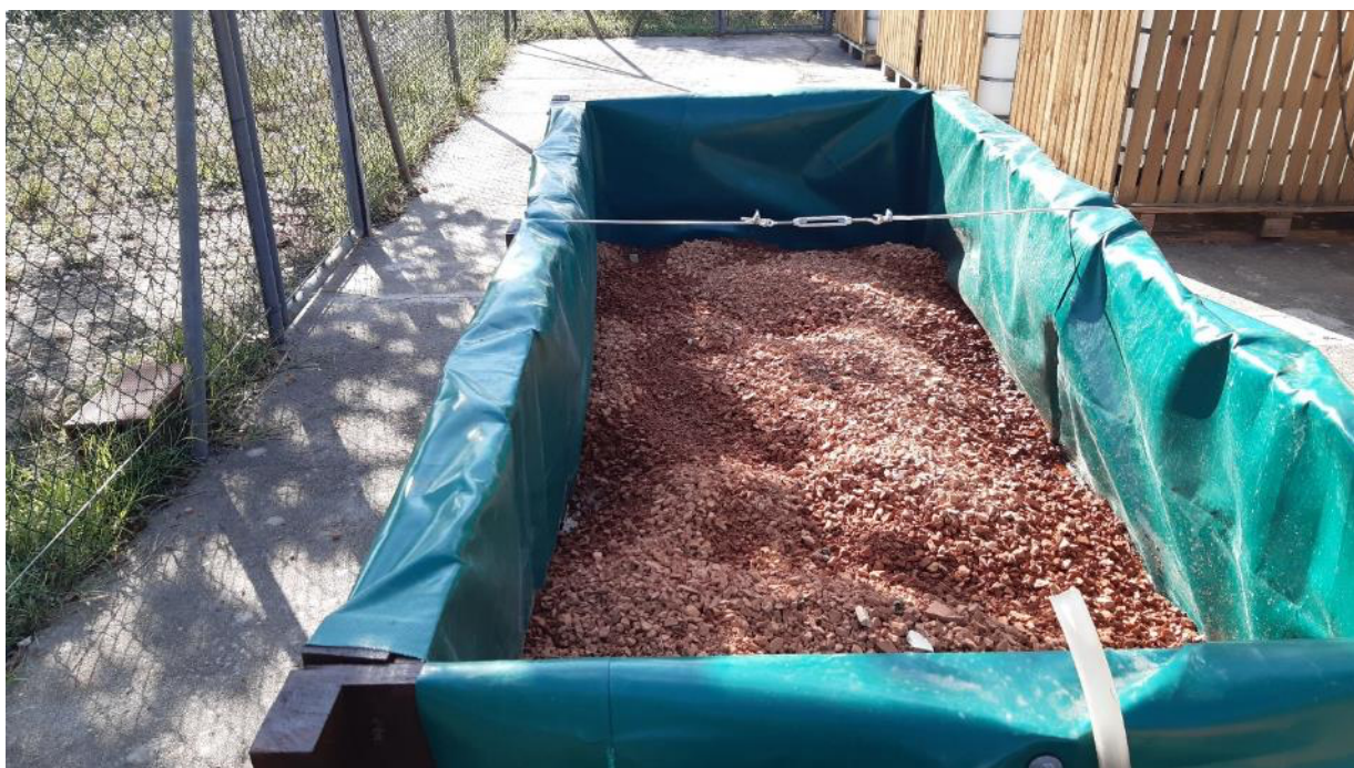
Fig. 6.14 – Enchimento da ZHC com fragmentos de tijolo de construção civil.
