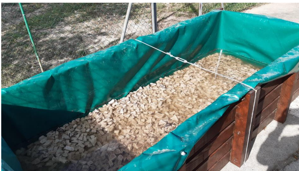
Fig. 6.13 – Pormenor do enchimento da ZHC com pedra de “moleanos”.
