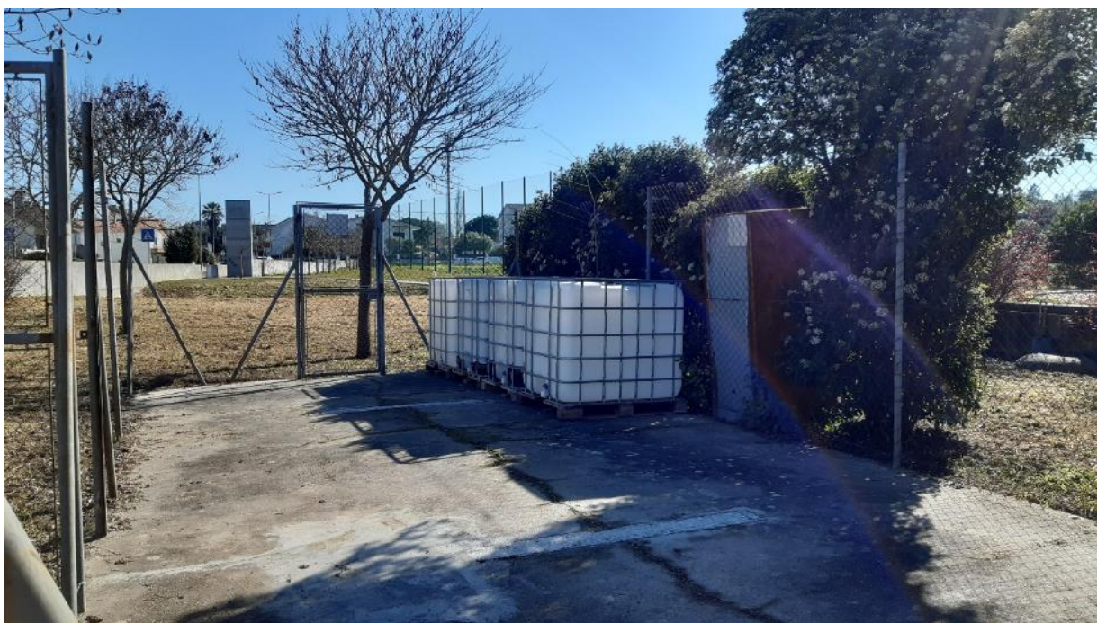
Fig. 6.6 – Instalação dos depósitos para armazenagem da água a tratar e tratada, na zona de operação do projeto.
