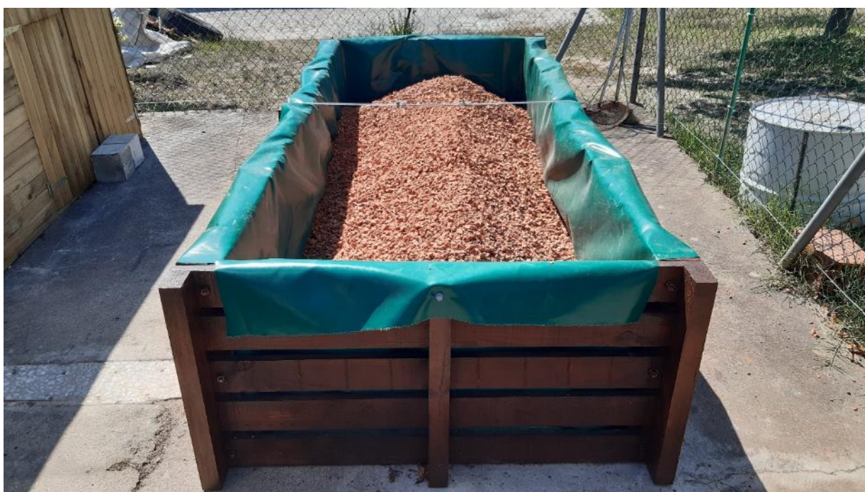
Fig. 6.15 – Preparação da ZHC para plantação das macrófitas.
