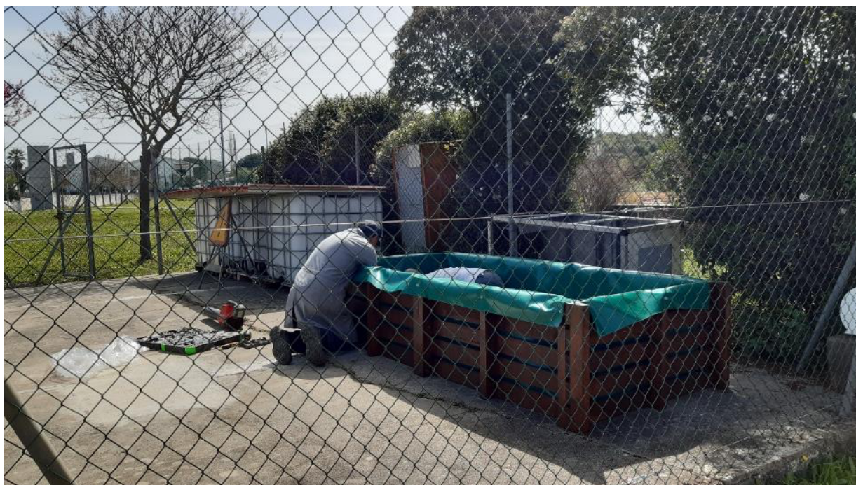
Fig. 6.7 – Instalação da ZHC modular na zona de operação do projeto.
