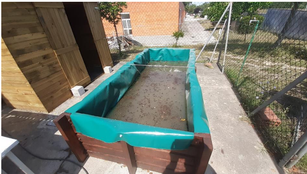
Fig. 6.12 – Enchimento da ZHC com pedra de “moleanos” (fragmentos de pedra calcária usada na construção civil), e validação da estanquicidade da tela face à carga do material.
