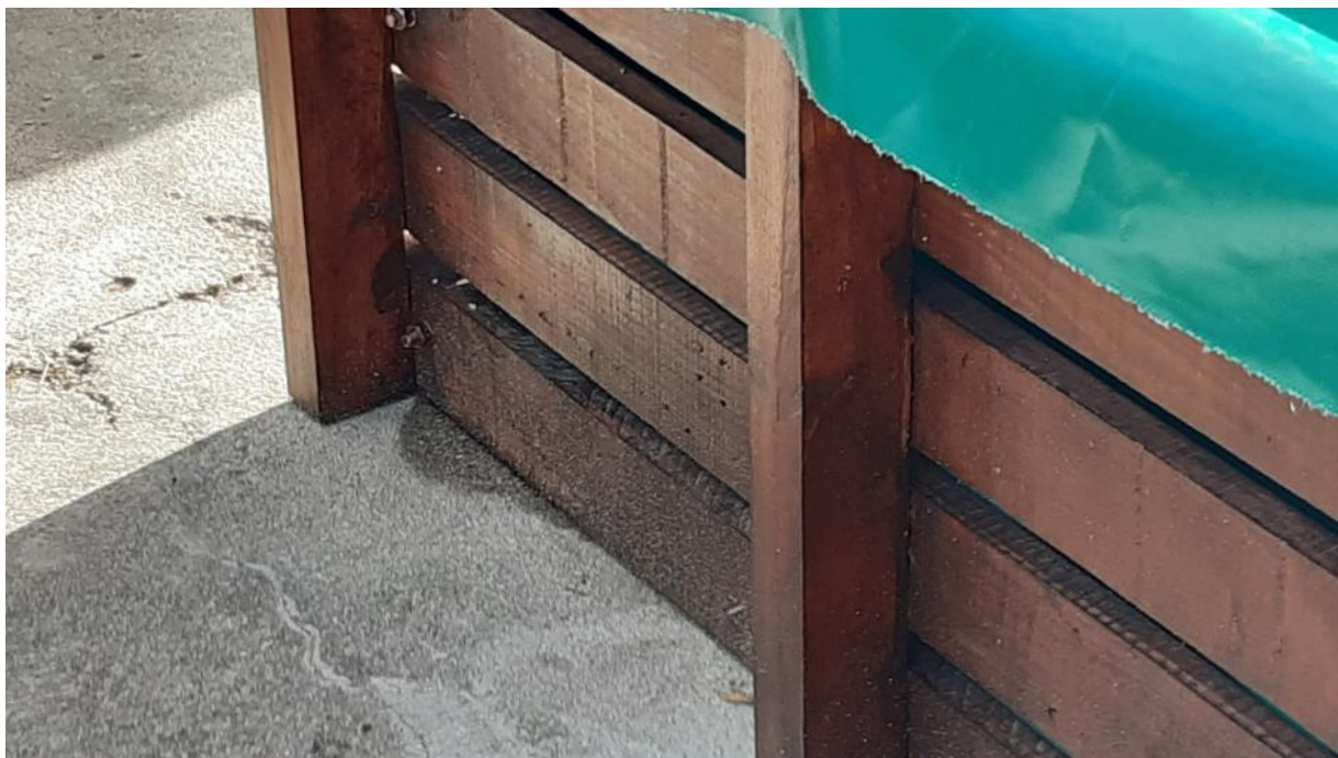
Fig. 6.11 – Realização de testes de estanquicidade da tela de impermeabilização e de circulação da água, assim como identificação de pontos de fuga para reparação.
