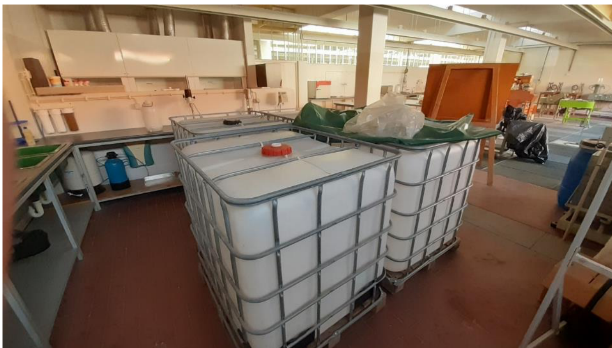
Fig. 6.5 – Preparação dos depósitos para armazenagem da água a tratar e tratada, no Laboratório Tecnológico do IPT.
